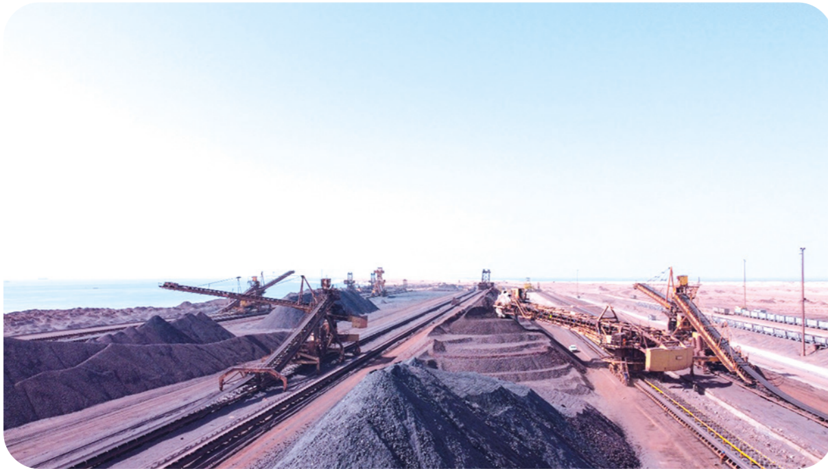
Reprise du minerai dans la zone portuaire de Nouadhibou
