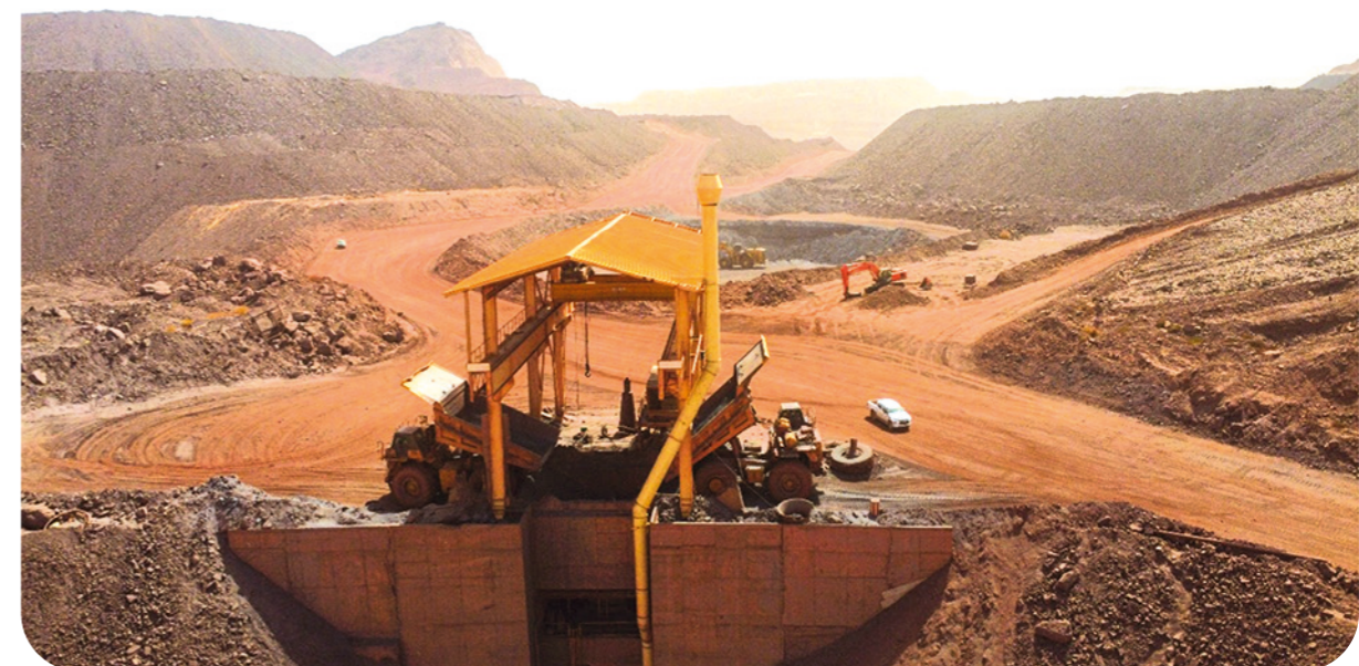
Concasseur du site TO14 près de Zouerate
